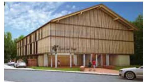
Im neuen Gästehaus entstehen 36 große Zimmer
