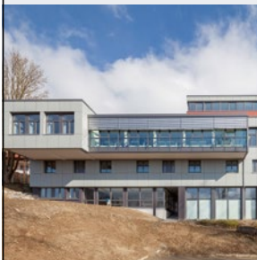
Die Jugendherberge in Überlingen nach der Sanierung
