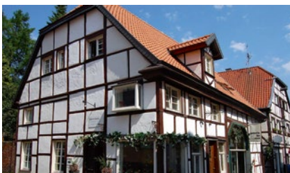
Fachwerkhaus in der „Guten Stube“
