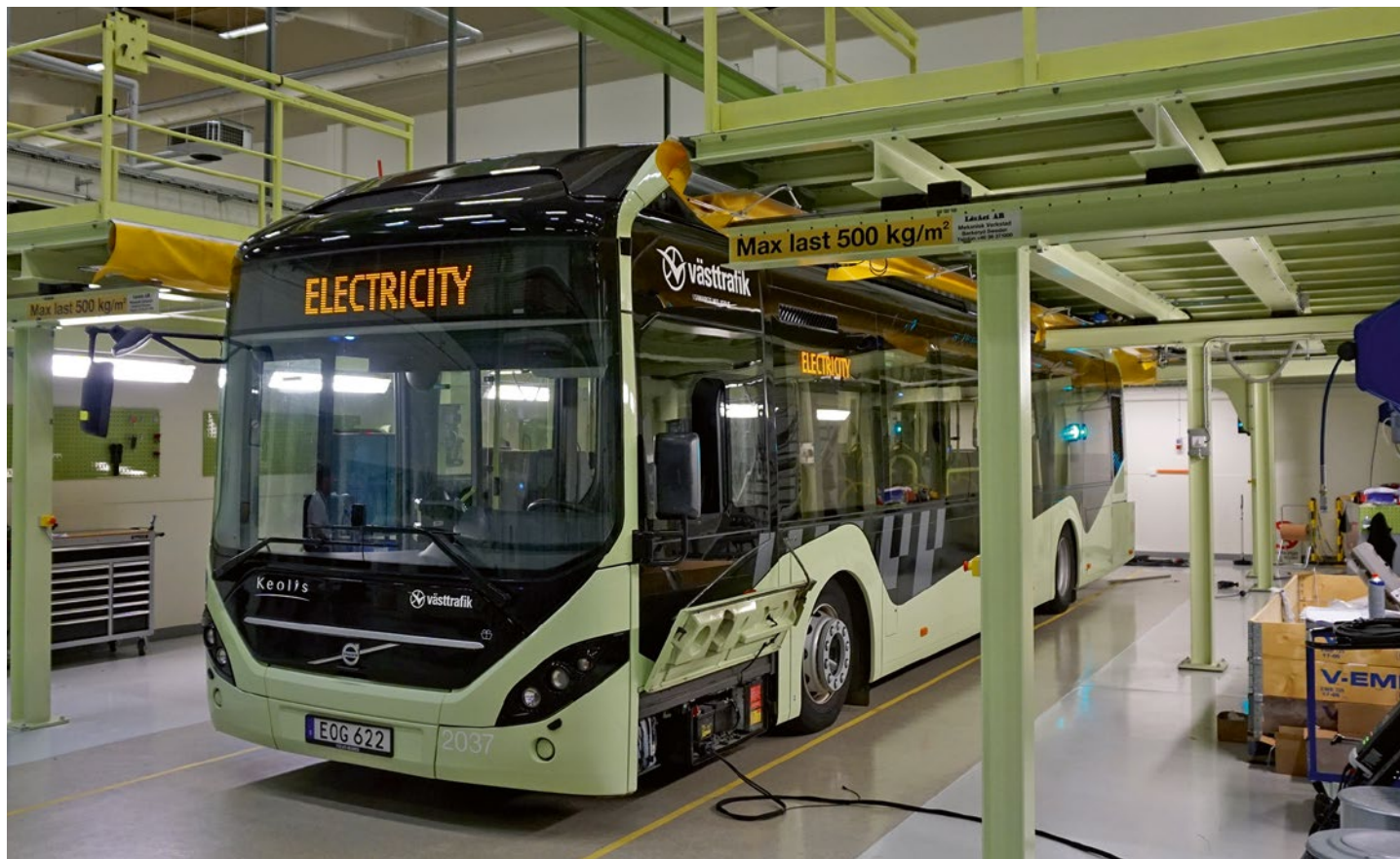
Für Wartungs- und Servicearbeiten eines Elektrobusses wird man in der Werkstatt neue Wege gehen
