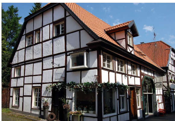
Fachwerkhaus in der „Guten Stube“
